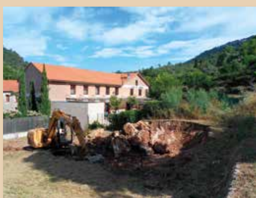
Terrassement pour la cour de l'école par l'entreprise Le Particulier du Terrassement
