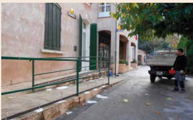
Mise aux normes des accès pour les personnes handicapées
