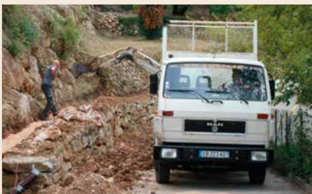
Pose d'une gaine pour le passage des cables d'alimentation des éclairages du chemin d'accès aux écoles
