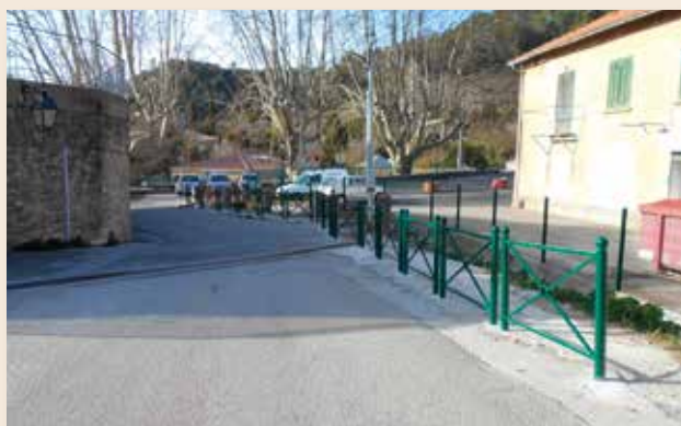
Pose de barrières de sécurité
