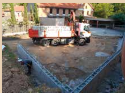
Construction des murs de soutènement par l'entreprise Urbavar pour la cour de l'école
