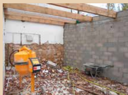
Par le département des WC Peiresc en cours d'achèvement
