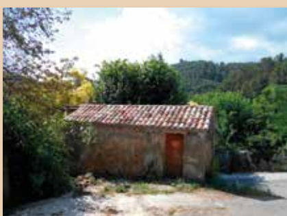
Rénovation de la toiture du cabanon de Valbelle par l'entreprise Garoute
