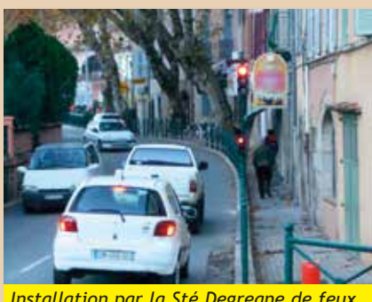
Installation par la Sté Degreane de feux tricolores récompense pour limiter la vitesse à 30 km/h au coeur du village
