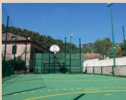
Installation d'un City Park et rénovation de l'aire d'entraînement du tennis
