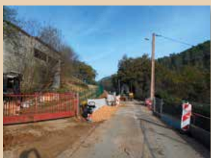
Création d'un mur de soutènement pour l'élargissement du Chemin de Ferrantu. Travaux réalisés par le CCVG.
